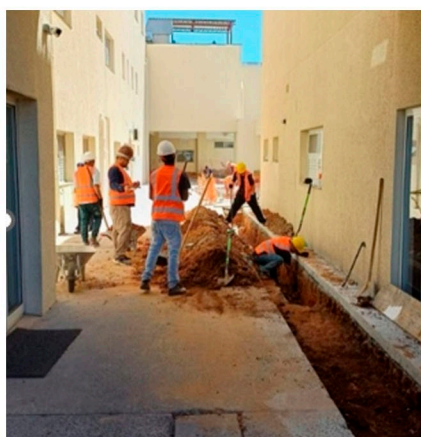
Figura 9 - Nova tubulação de águas pluviais e esgoto
