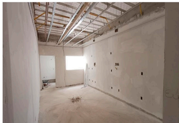
Figura 8 - Clínica 3 em fase de acabamento
